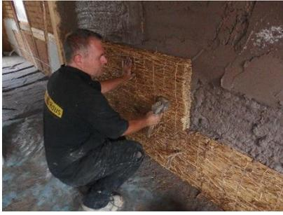
Daraufhin konnten wir zügig die zugeschnittene Platte perfekt einbauen und einen sauberen Anschluss an die Dachschräge herstellen. So haben wir dieses Verfahren mit einigen anderen Platten wiederholt und die halbe Wand somit gedämmt und dann verputzt.
